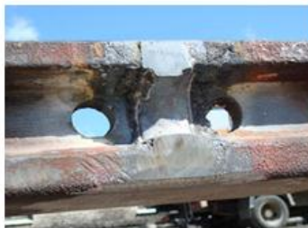
Вид рельса после чернового шлифовки, проводимая сразу же после снятия грата
