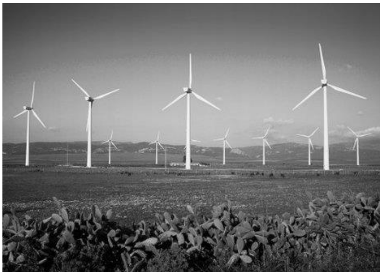
Рис.1. Ветроэнергетическая станция (ВЭС)
