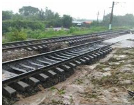
3-расм. Намлик ошиши натижасида ер полотносини зарарланиши.
