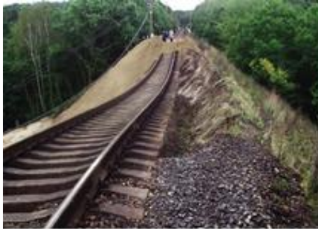
2-расм. Ер полотносида кўчкининг ҳосил бўлиши.
