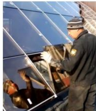
Рис.2 – Монтаж склопакетів (триплекс)
