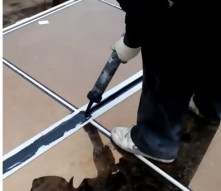
Рис. 5– Нанесення на шви герметика Dou Korning 591
