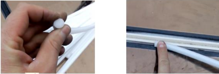
Рис. 3 – Укладання ПВХ ущільнювача серії ТПСК на термовставку ригелю.
