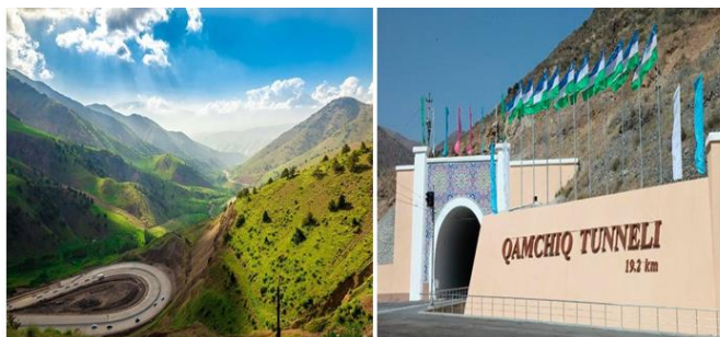
1-2-rasm. A-373 "Toshkent-O'sh" avtomobil yo'lining davon qismi
